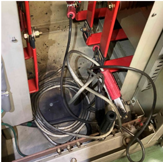
短絡によって焦げた床面
