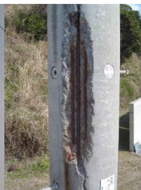
塩害による縦ひびと剥離
