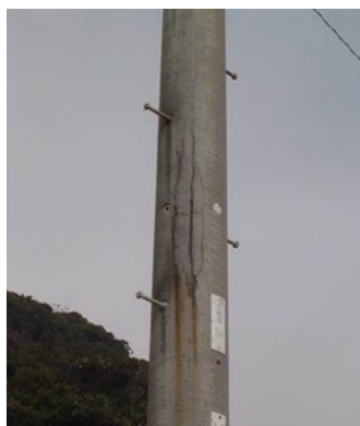
塩害による縦ひびと剥離
