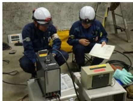
ケーブル劣化診断
