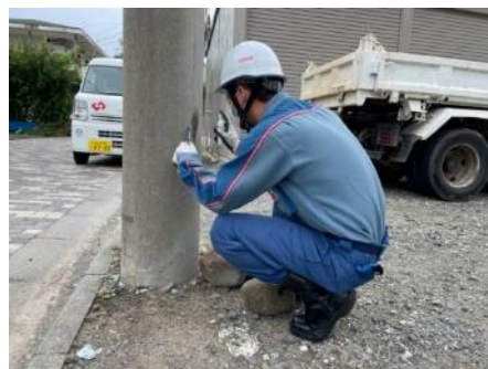
コンクリート柱診断
