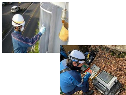
設備診断・補修
