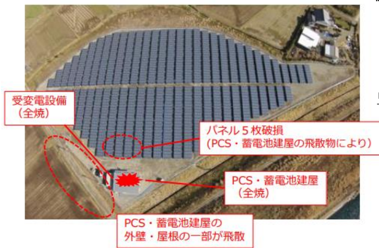
太陽電池発電所全景及び被害状況
