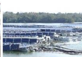
太陽光発電設備崩壊(暴風)
