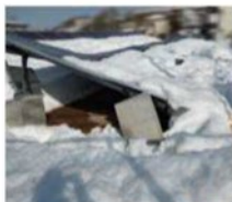
積雪による太陽電池発電設備の破損
