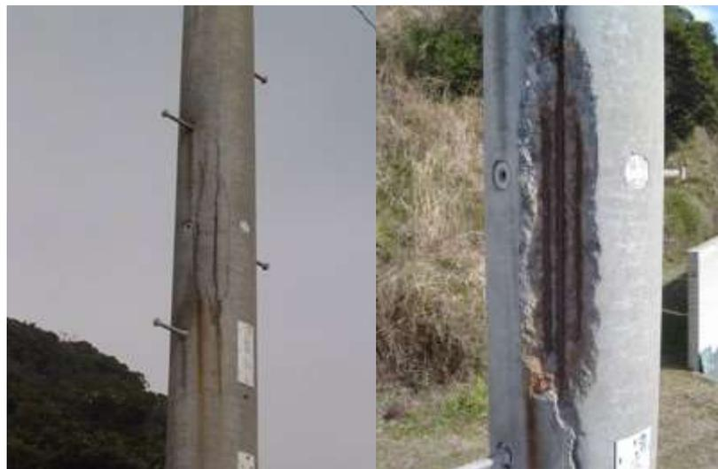
塩害による縦ひびと剥離
