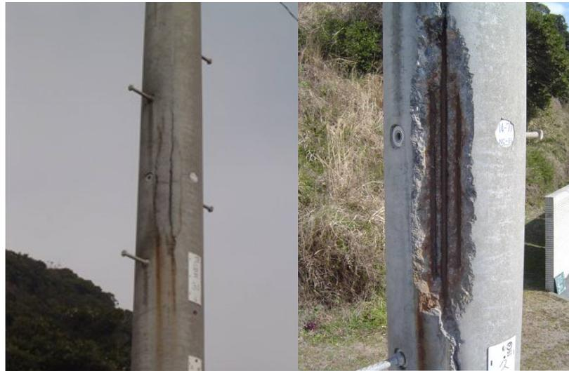
塩害による縦ひびと剥離
