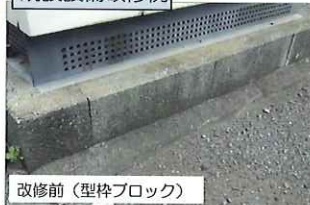
既設設備改修例
