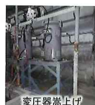
変圧器嵩上げ
