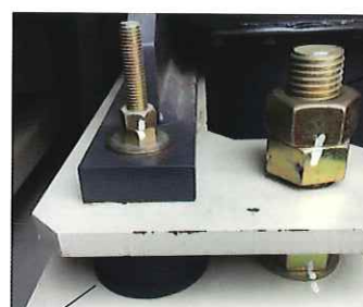
通しボルト形耐震ストッパー(上) 通し穴クリアランス(右)
