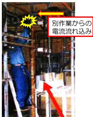
交換作業中に断路器に触れ感電
